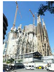
La tour centrale en construction en 2014.
