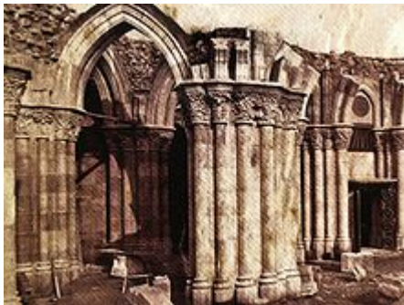
Travaux de la crypte (1885).
