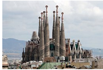
La Sagrada Família en 2009 La tour de la Vierge en travaux.
