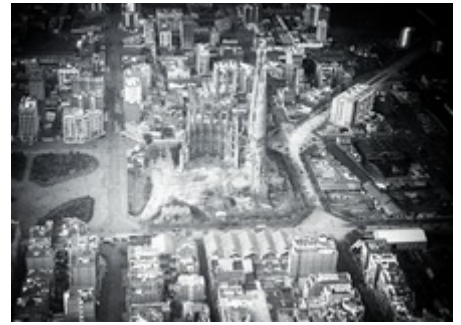
Sagrada Família en construction en 1930. Photographie de Walter Mittelholzer, ETH-Bibliothek
