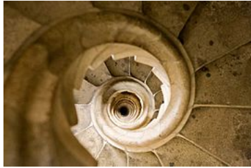
Escaliers hélicoïdaux à l'intérieur des tours.
