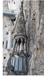
Détail de la façade de la Passion.
