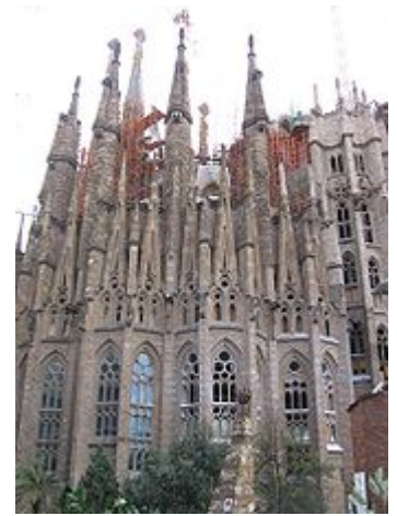
L'abside en construction en 2008.
