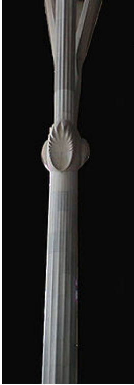
Colonne de la nef centrale avec son nœud ellipsoïdal.
